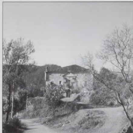
MOIUA TORRE Marqueses de Rocaverde
