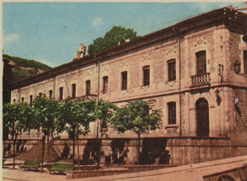
Edificio del Juzgado de Primera Instancia.
