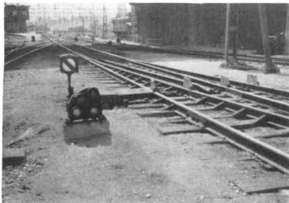
X 1292 Fig. 30. Señal baja y farol de calce de vía.
