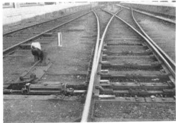
X 1295 Fig. 22. Aguja con espadines de resorte talonables.
