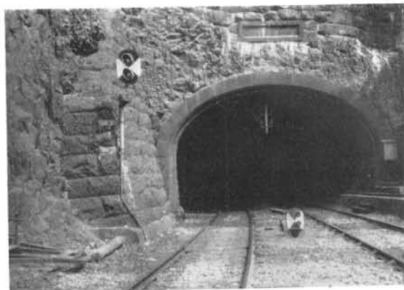
X 1289 Fig. 27. La entrada sur del túnel.
