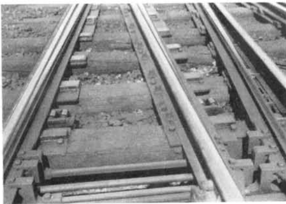
X 1283 Fig. 20. Cojinetes de rodillos.
