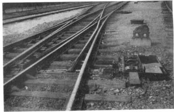
X 1284 Fig. 21. Aguja de cruzamiento doble, con dispositivo de maniobra doble.
