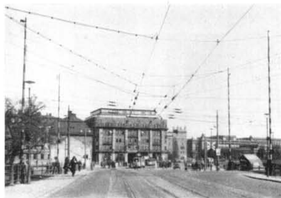
X 1280 Fig. 18. El paso a nivel de Jakobsgatan, entre la línea de tranvías (600 V) y la línea del ferrocarril (16 000 V).
